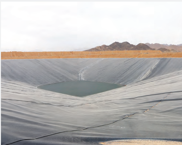
سد باطله برای جمع‌آوری پسمان‌های مایع کارخانه تولید کیک زرد
