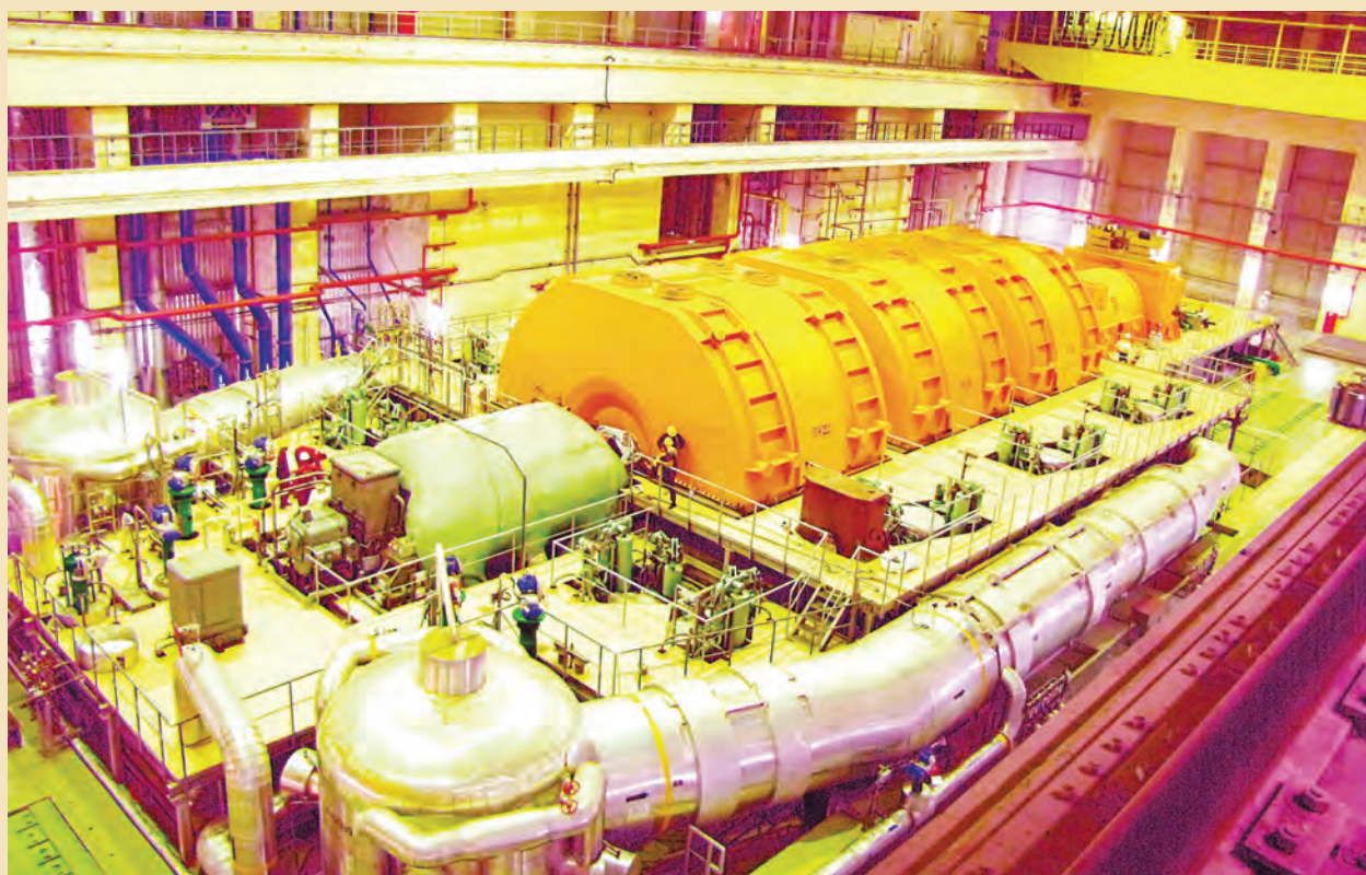
توربین فشار قوی و توربین‌های فشار ضعیف نیروگاه هزار مگاواتی بوشهر
