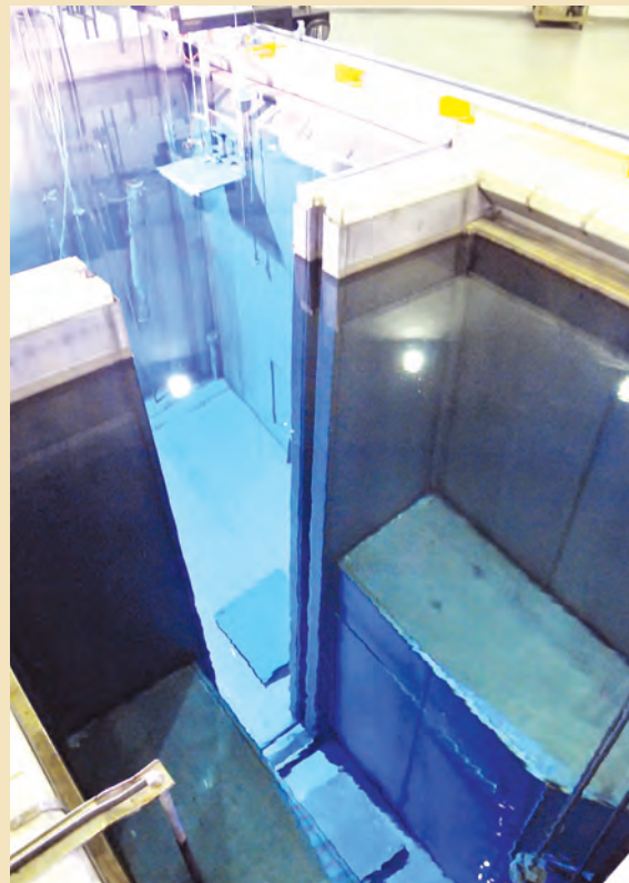
استخر شماره یک و محل قرار گرفتن قلب راکتور تهران
