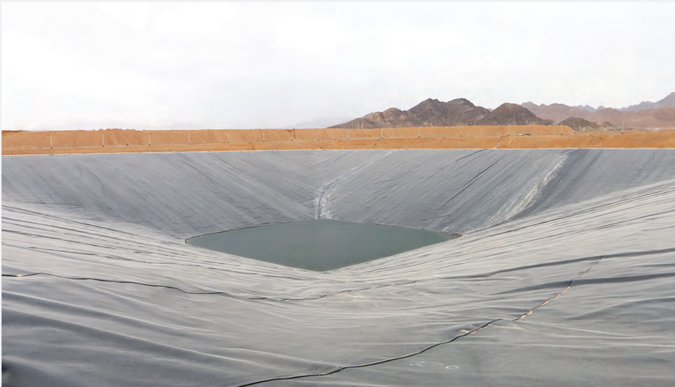
سد باطله برای جمع‌آوری پسمان‌های مایع کارخانه تولید کبک‌زرد
